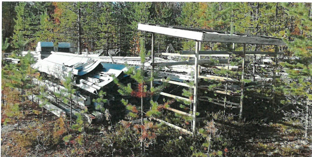
Kuva 8. Teollisuushallin osia, jotka on määrätty poistettavaksi 31.12.2021 mennessä.
