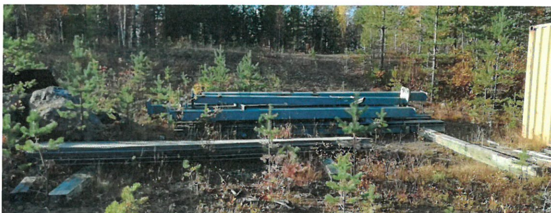
Kuva 6. Teollisuushallin osia, jotka on määrätty poistettavaksi 31.12.2021 mennessä.
