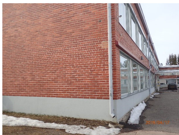
Kuva 11. Sadevesi lasketaan rakennuksen vierelle. Nurmipinta kiinni sokkelirakenteissa.
