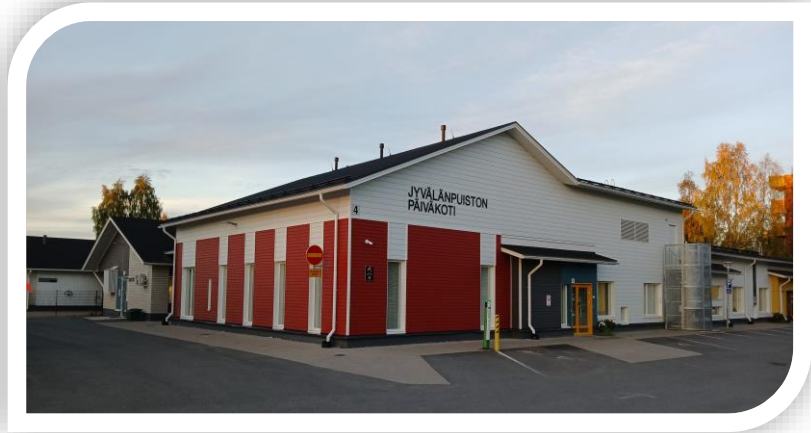
Kuva 2: Vuonna 2020 käyttöön otettu saneerattu Jyväluipiston päiväkotii
