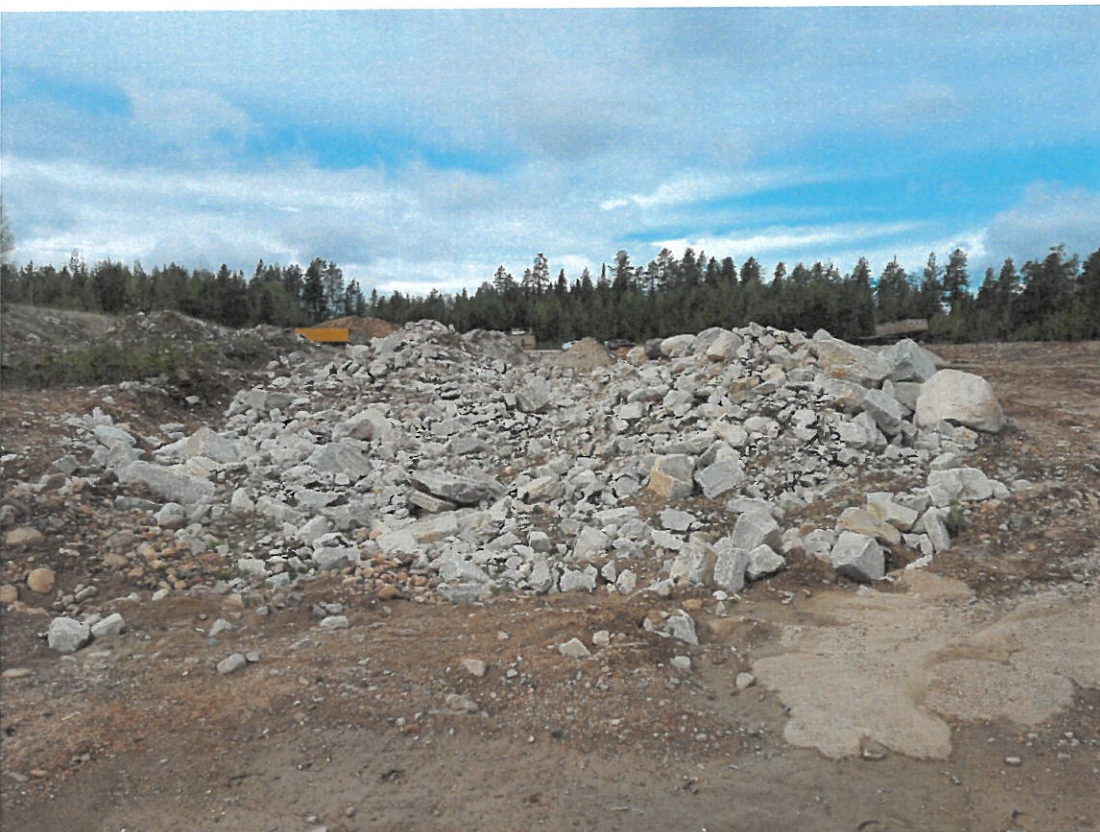
Kuva 7. Pyhäntunturin hotellityömaalta murskattavaksi tuotuja kiviä.
