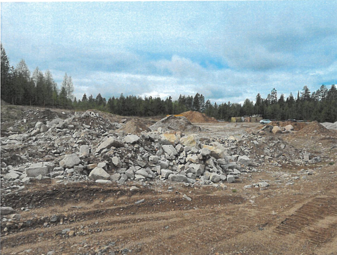
Kuva 6. Kiinteistöllä olevia varastokasoja ja muualta tuotuja kiviä.
