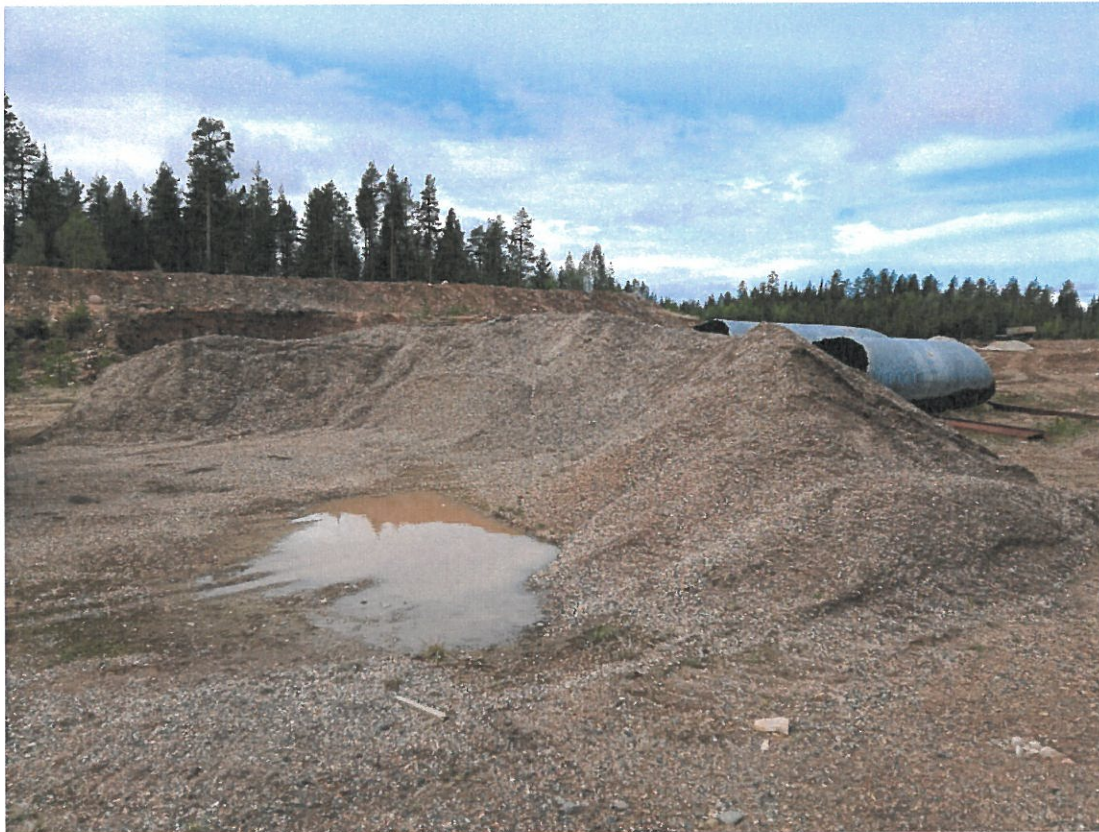
Kuva 8. Alueelle lammikoituu vettä.
